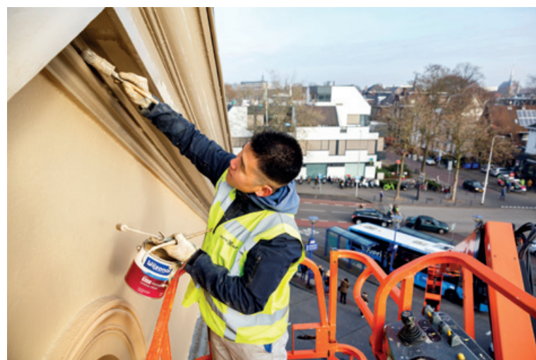
Johan Joosten van de Rutten Groep verwerkt roodkleurige Wijzonol LBH 540 op een kozijn van het station.
