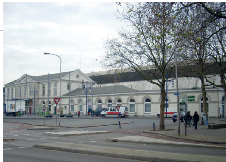
Het stationsgebouw in Zwolle voor het onderhoudsschilderwerk begon.
