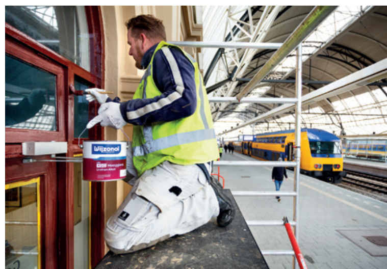
Johan Joosten van de Rutten Groep verwerkt roodkleurige Wijzonol LBH 540 op een kozijn van het station.
