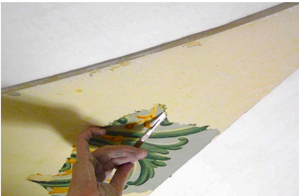
Met een scalpelmessje worden oude verflagen voorzichtig verwijderd, met bijzondere verrassingen tot gevolg
